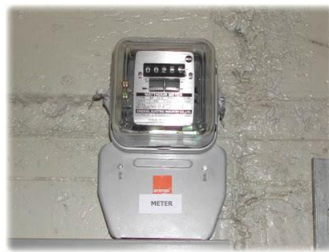
(ข) การติดตั้งใช้งาน
